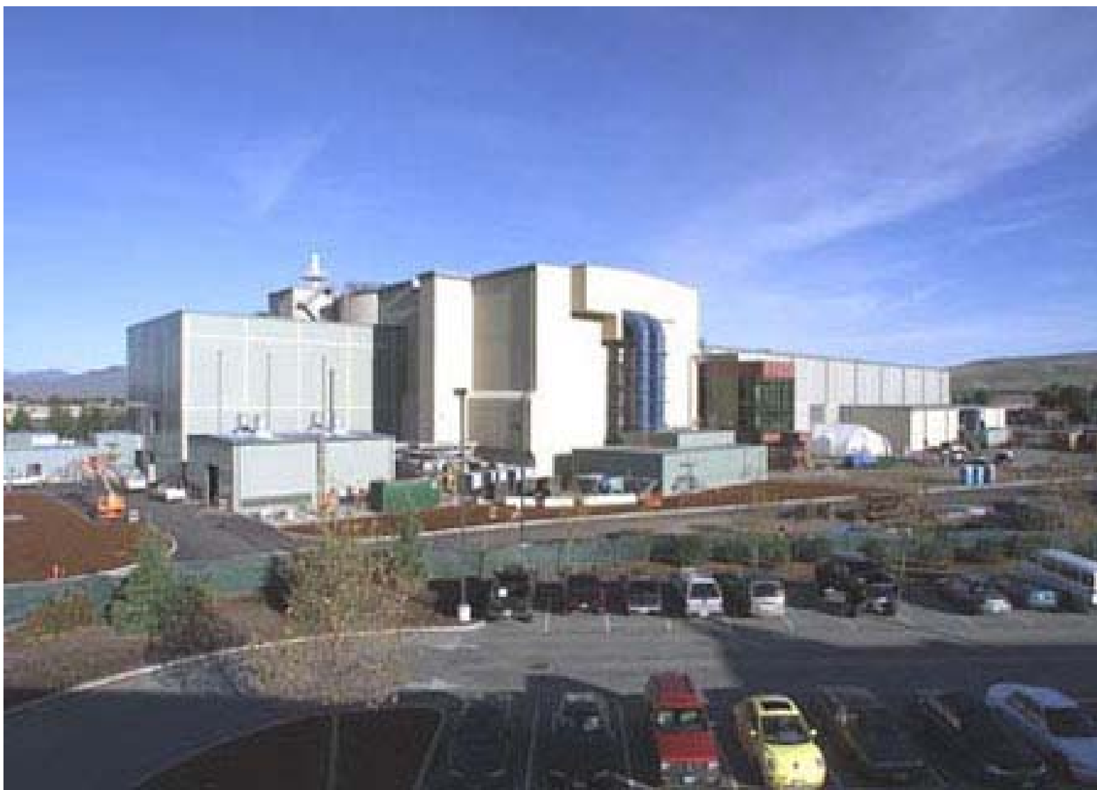
Строительство NIF (National Ignition Facility) - сегодня
