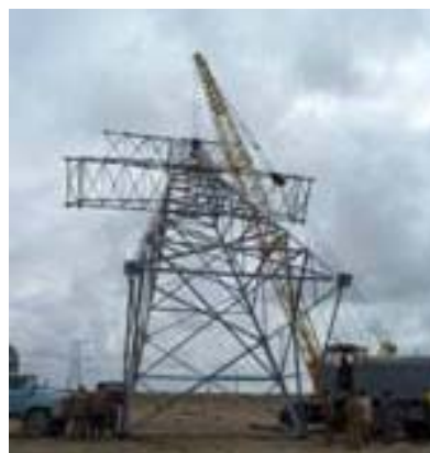
Установка мачт и прокладка линии 220КВ
